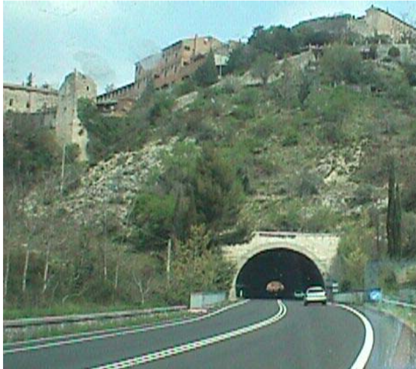
Fig. 5.16 - Imbocco galleria lato sud
