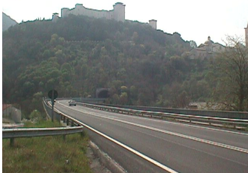
Fig. 5.17 - Imbocco lato nord
